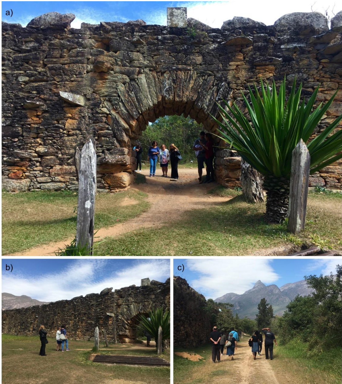
Figura 21 – a) Detalhe do arco no Bicame de Pedra a partir da estrada que dá acesso ao sítio; b) vista parcial do bicame; c) vista parcial da Serra do Caraça a partir do Bicame de Pedra.
